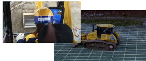
ICT建機による施工
