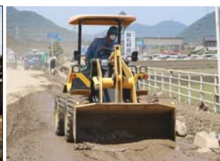
浸水被害によって国道486号に堆積した土砂を撤去する災害協定協力企業
