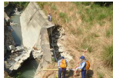
広島県三原市でコンクリート護岸の被災状況調査を実施 (北海道開発局)
