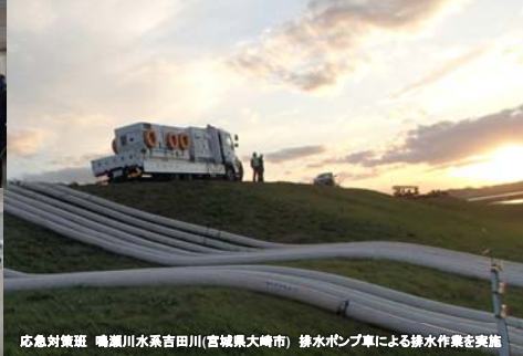
応急対策班 鳴瀬川水系宮田川(宮城県大崎市) 排水ポンプ車による排水作業を実施
