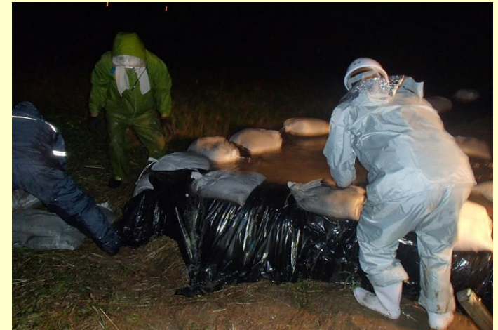
漏水止の応急工事の実施状況 (H28北川・宮崎県)
