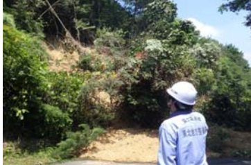
岡山県倉敷市で道路法面崩落により全面通行止となっている被災箇所を調査(東北地方整備局)
