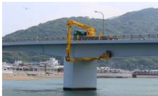
橋梁点検車による調査
